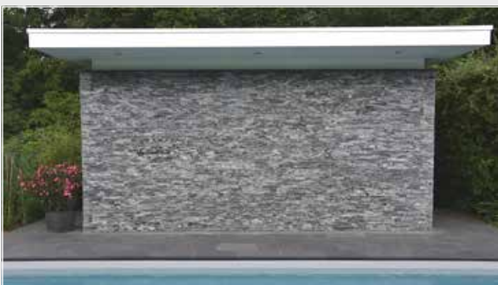
Wandverkleidung mit Granit-Riemchen
