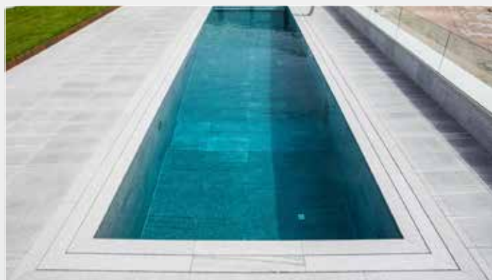
Betonschwimmbecken mit Granit-Auskleidung, Granitrinne & Granit-Wandverkleidung
