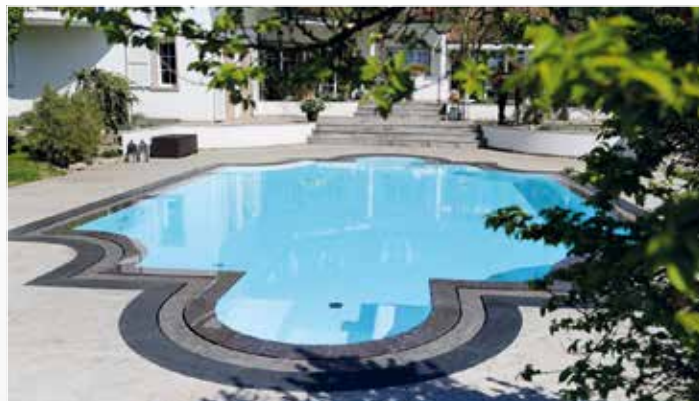
GFK Schwimmbecken mit Granitrinne
