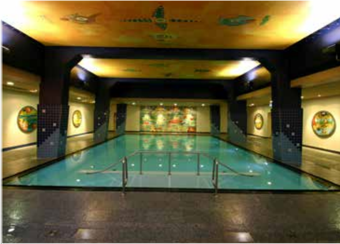
Folienschwimmbecken mit massiver Granit-Überlaufrinne
